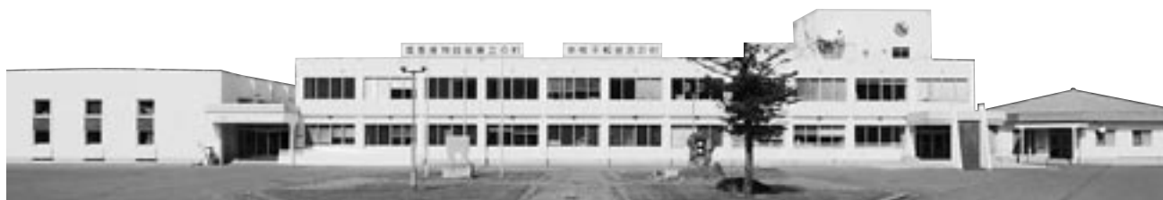
忠類村役場 1階部分は住民課窓口及び教育委員会事務室のほか、コミュニティ施設が設置されており、左の建物がコミュニティセンター大ホール、右が忠類歯科診療所
